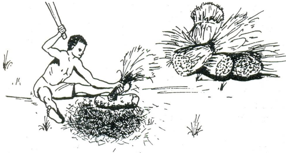
Fig. 5 : Voici un constructeur entrain de hacher la paille devant servir pour la construction d'un grenier en terre
